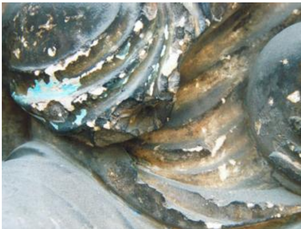
Fig. 3 - Saint-Pierre-le-Moutier, vêtement du Christ (cliché J. Rollier).
