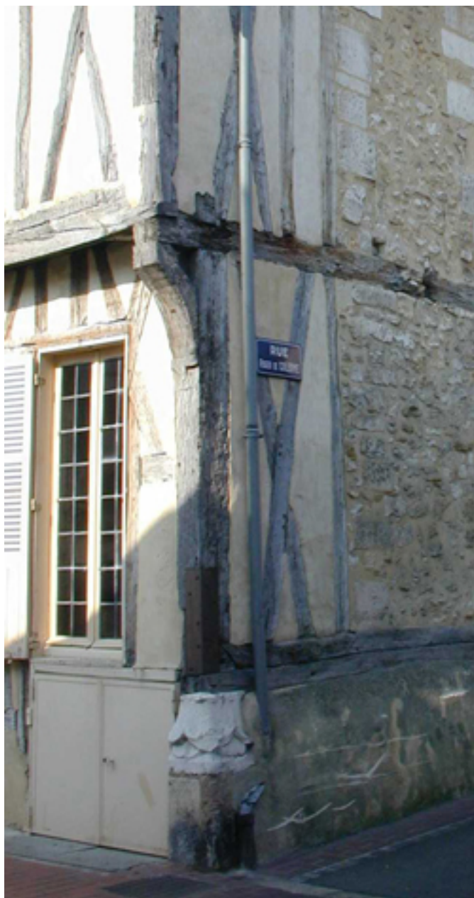
Figure 3 : Auxerre, maison située au 10, rue Haute-Perrière. (Cliché F. Burguière-Labrunie).
