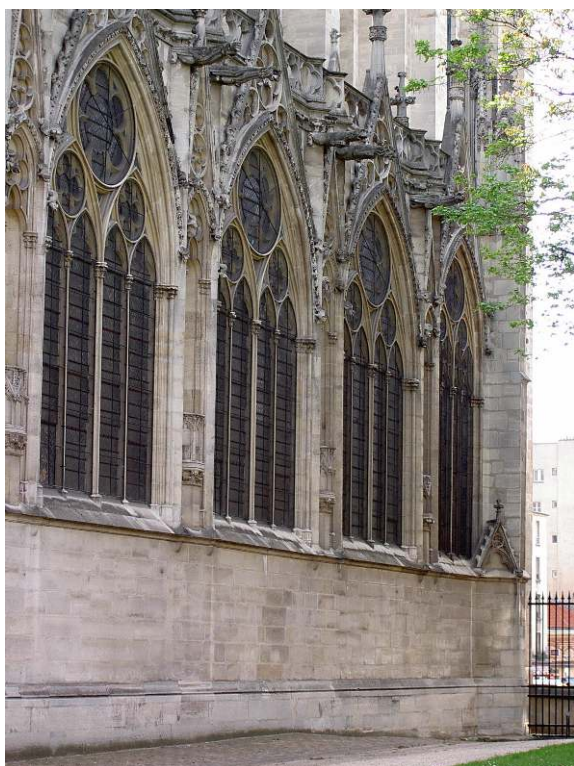
Vue de la façade septentrionale des chapelles latérales nord. Cl. D. Berné
